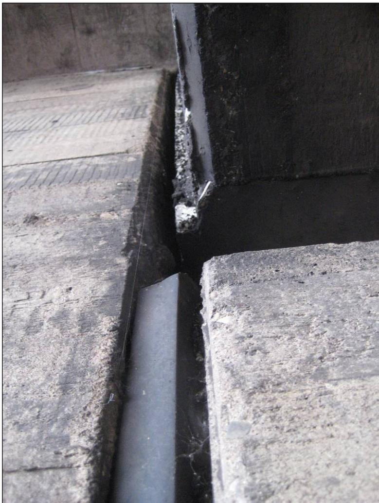
**Abb. 12: Brückenbauwerk 6: Hier fehlt, wie auch bei Bauwerk 3 die Gummidichtung oberhalb der Auflagebank**
