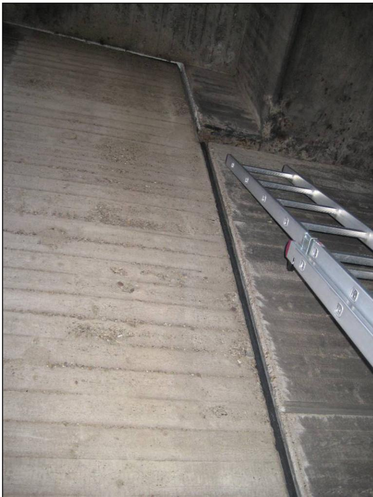
**Abb. 13: Brückenbauwerk 7: Widerlager mit horizontaler, gummiverfüllter Fuge und gut einsehbarem Spalt zwischen Auflagebank und Oberbau**
