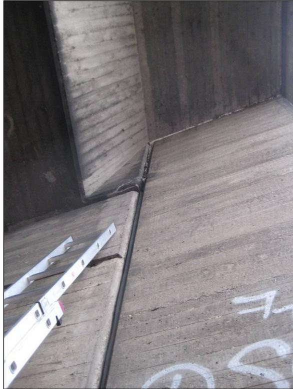
**Abb. 11: Brückenbauwerk 3: Vertikale Dehnungsfuge mit Gummidichtung; Die Fuge am Rande des Oberbaus (Bild rechts oben) weist keine ausreichende Tiefe für einen Hangplatz auf.**
