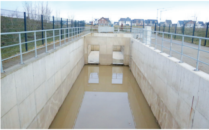
Regenrückhaltebecken für das Wohngebiet Allerheiligen.
