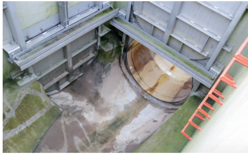
Technisch aufwendiges Bauwerk für Starkregenereignisse.
