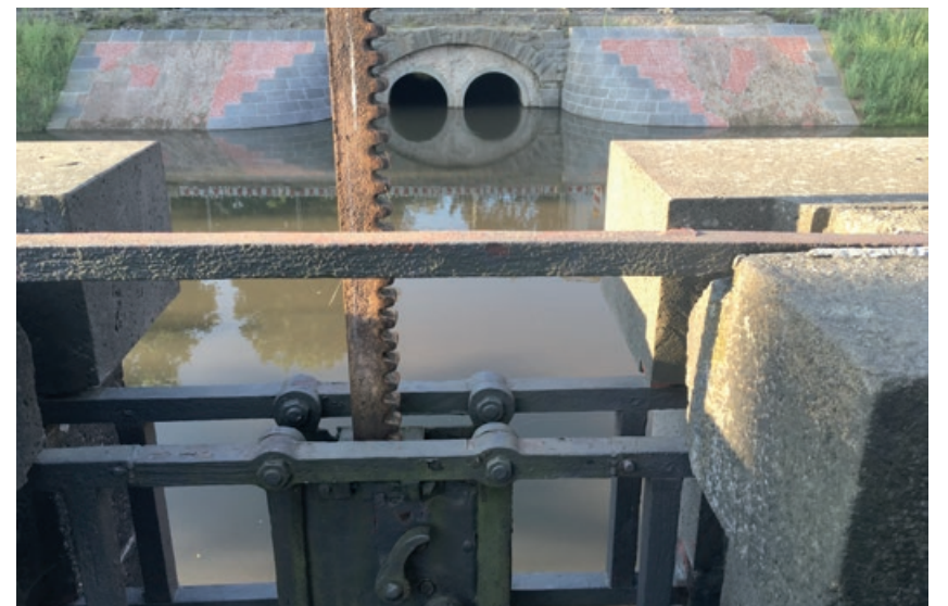
Blick vom Wehr Richtung Zulauf Obererft
