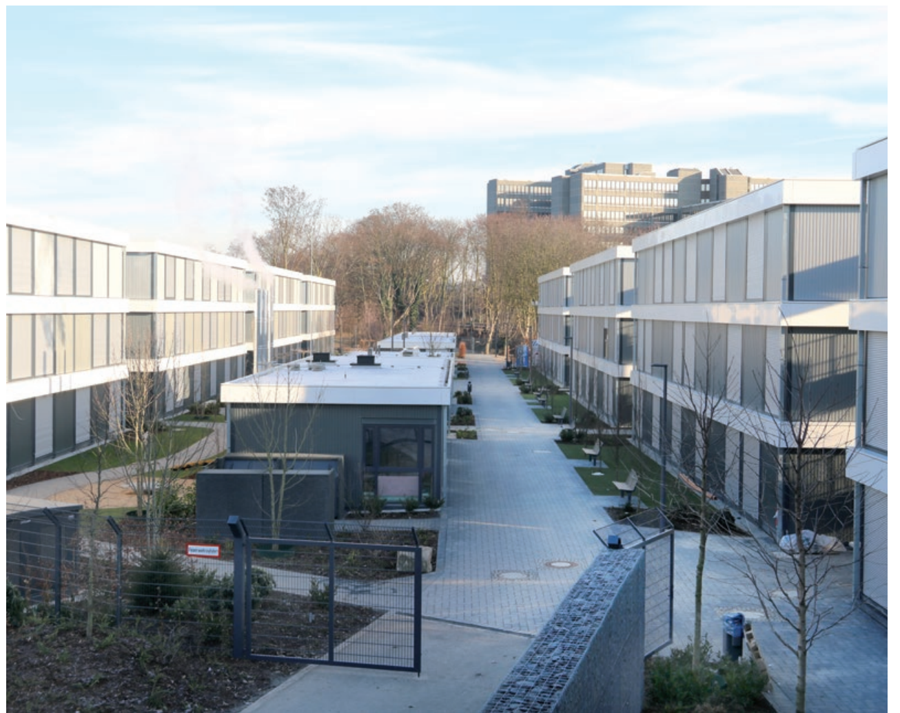
Blick in den Innenbereich der neuen ZUE
