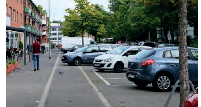
Abbildung 26: Fehlende Trennung von Verkehr und Seitenbereich
