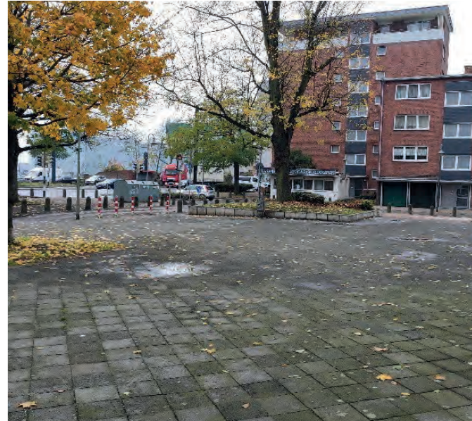
Abbildung 109: Hoher Versiegelungsgrad und schadhafte Beläge
