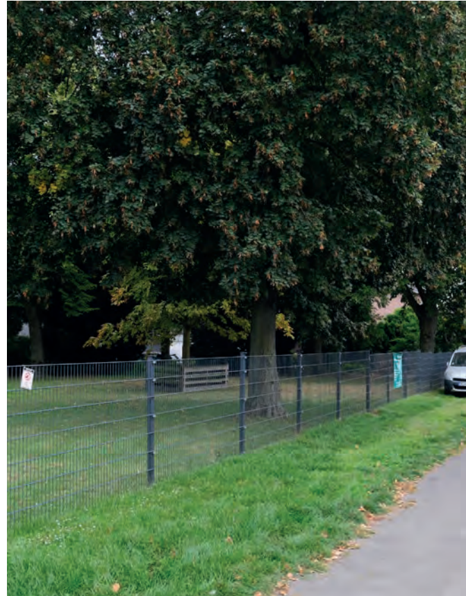
Abbildung 63: Eingeschränkter Zugang im Bereich der Pfarrwiese
