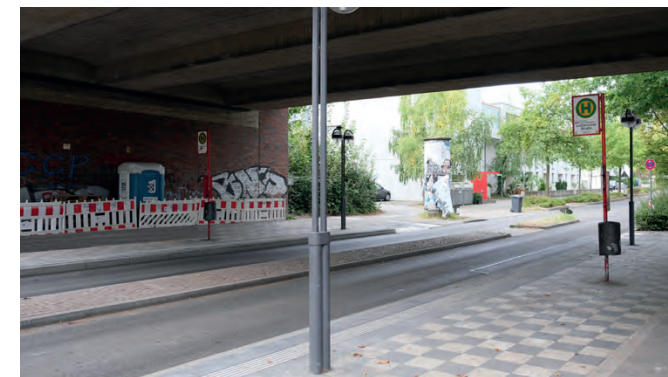
Abbildung 48: Haltestelle Lechenicher Straße Bestandssituation
