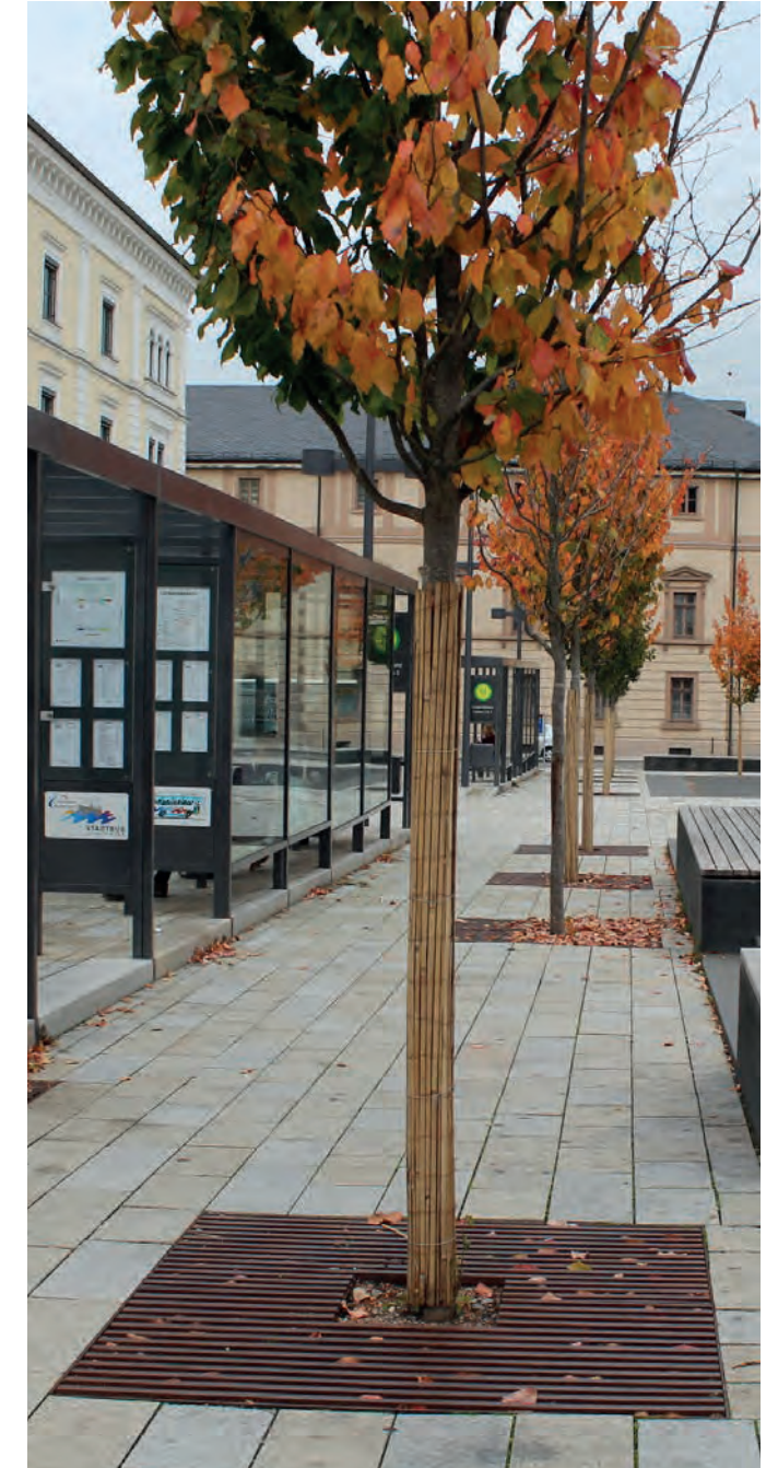
Abbildung 128: Wurzelschutzgitter innerhalb einer Gehwegsfläche
