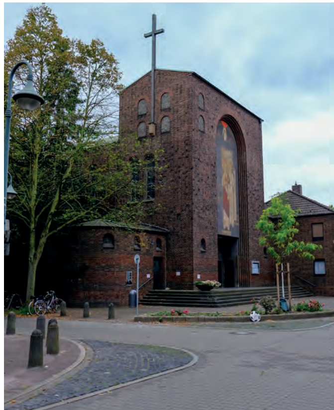
Abbildung 103: Denkmalgeschützte Kirche St. Barbara
