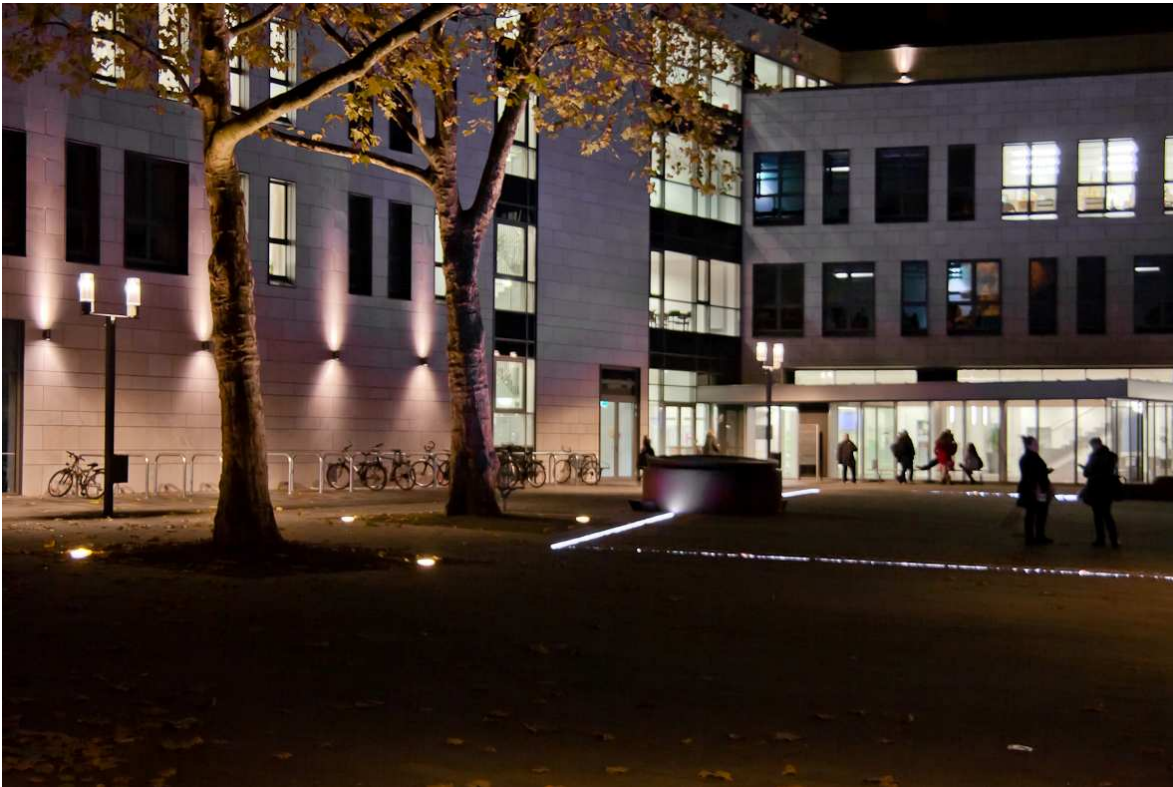
Fertige Platzgestaltung und Gebäude Romaneum Dezember 2012
